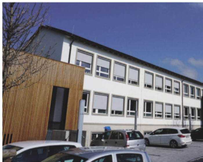
Das ehemalige Schulgebäude ist nun ein modernes Gesundheitszentrum.
