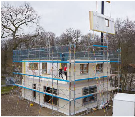
Ein großer Vorteil des Fertighauses ist die kurze Bauzeit. Foto: djd/WeberHaus
